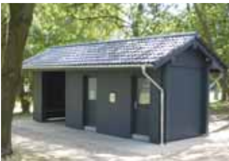
WC-Häuschen mit Schutzraum
