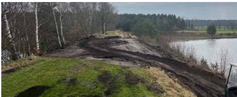
Die neue 12: links wird der Weg entstehen, rechts der neue Abschlag
