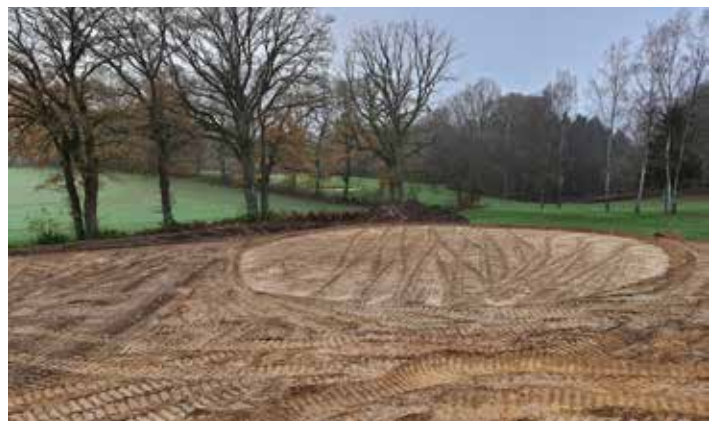
Grün der Bahn 11 im Bau
