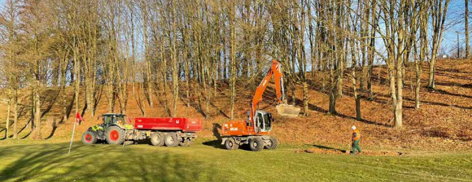
Arbeiten auf der DR
