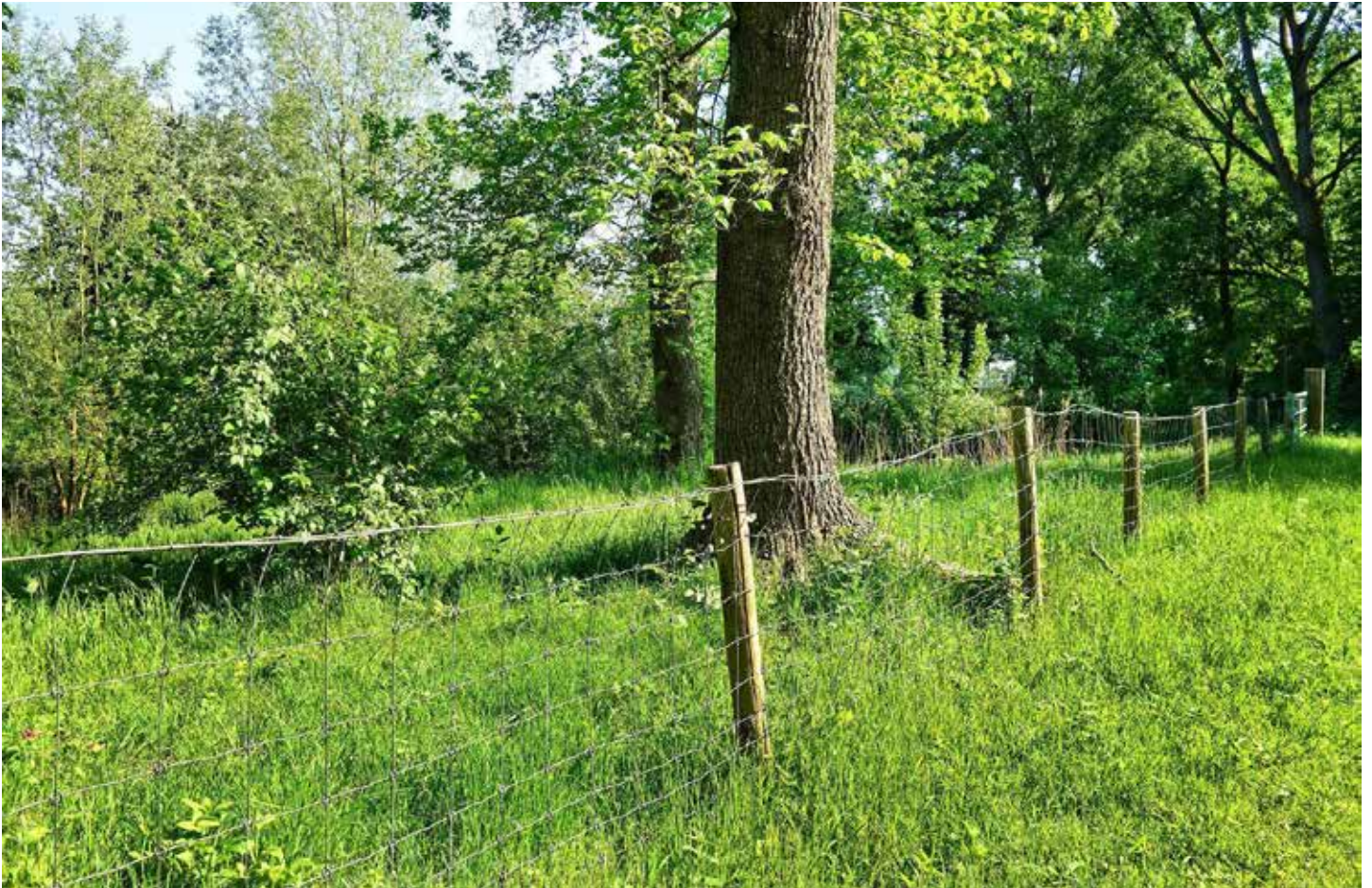
Aus Zaun: Es gilt die Innenseite zum Platz der Pfähle.
